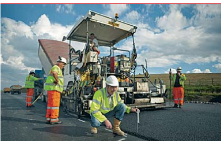
Bilfinger Berger realisiert und betreibt Infrastrukturprojekte auf drei Kontinenten: So auch in Schottland, wo das Unternehmen das größte Straßenverkehrsprojekt des Landes geplant, finanziert und gebaut hat und nun den Betrieb verantwortet
